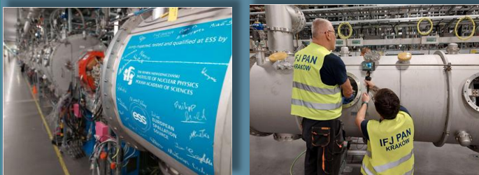
Inspekcja oraz przygotowanie modułów do instalacji w tunelu. 13 spoke cryomodules.
